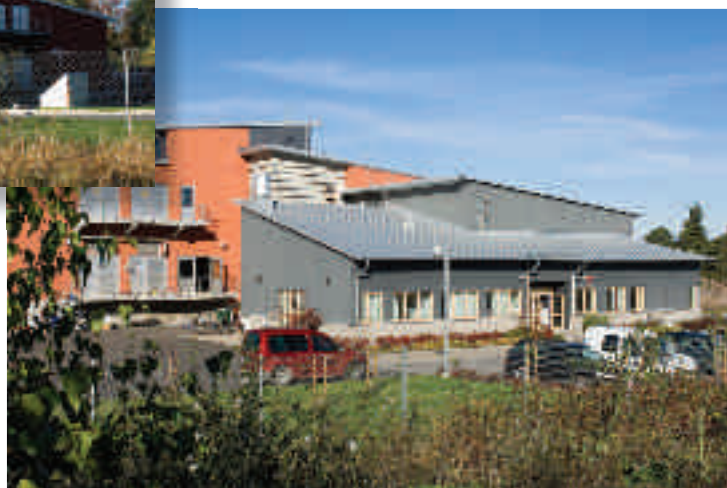
Vattenverket i Gränby.
