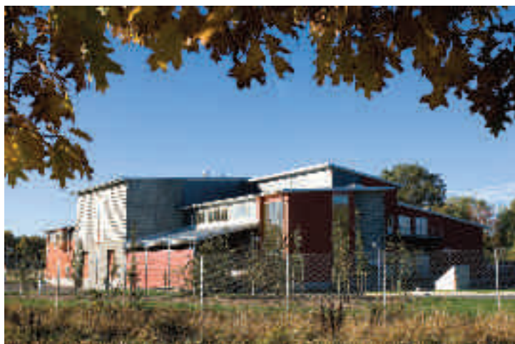
Vattenverket i Bäcklösa.
