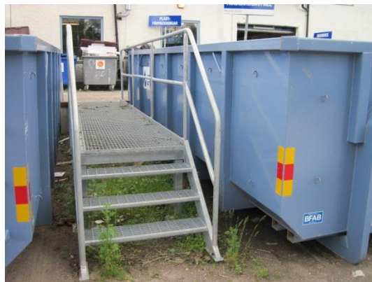
Bilder: "Rampen" på Almunge återvinningscentral. Bilderna ska endast ge en uppfattning om hur de förlängda trapporna är utformade.
